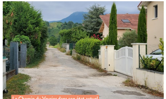
Le Chemin du Veyrier dans son état actuel
